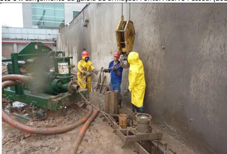
Foto 05: Instalação do tubo junta. Fonte: Acervo Pessoal (2014).
