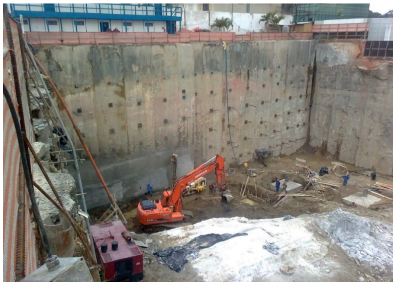
Fotografia 4 - Aspecto geral de parede diafragma Fonte: Acervo Pessoal (2011)
