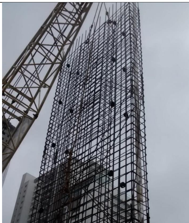
Foto 04: Lançamento da gaiola de armação. Fonte: Acervo Pessoal (2014).
