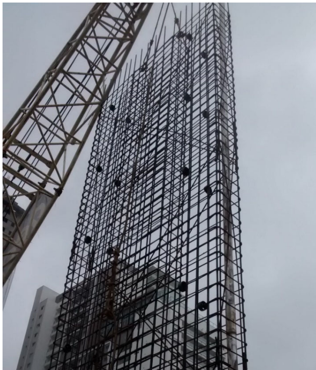
Fotografia 2 - Lançamento da gaiola de armação Fonte: Acervo Pessoal (2014)
