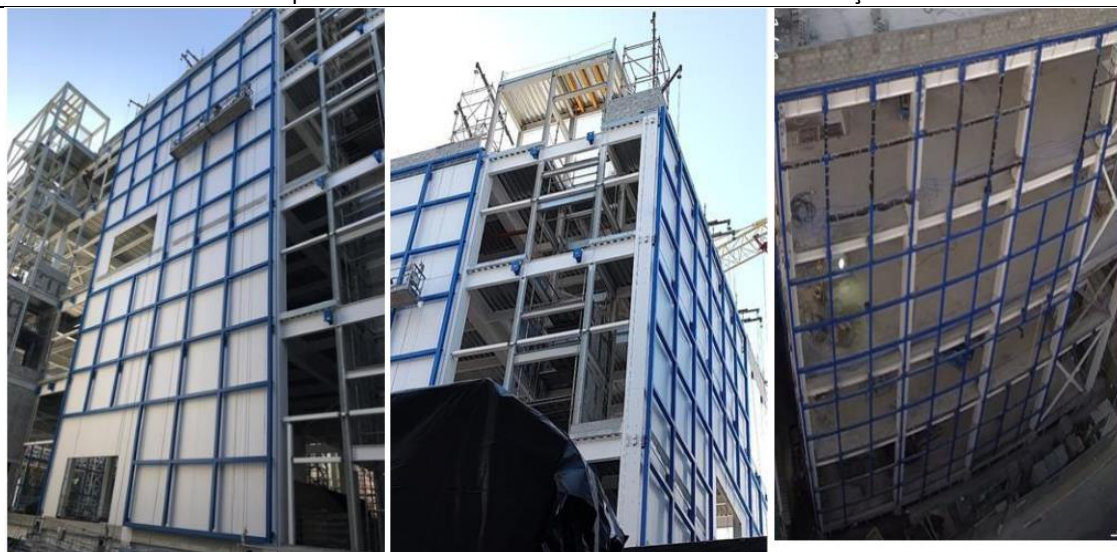
Foto 02: Estrutura metálica de fachadas típicas. Fonte: Acervo de fiscalização de obras.
