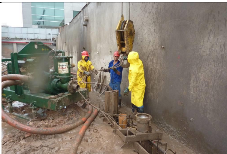
Foto 05: Instalação do tubo junta. Fonte: Acervo Pessoal (2014).
