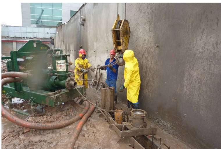
Fotografia 3 - Instalação do tubo junta Fonte: Acervo Pessoal (2011)
