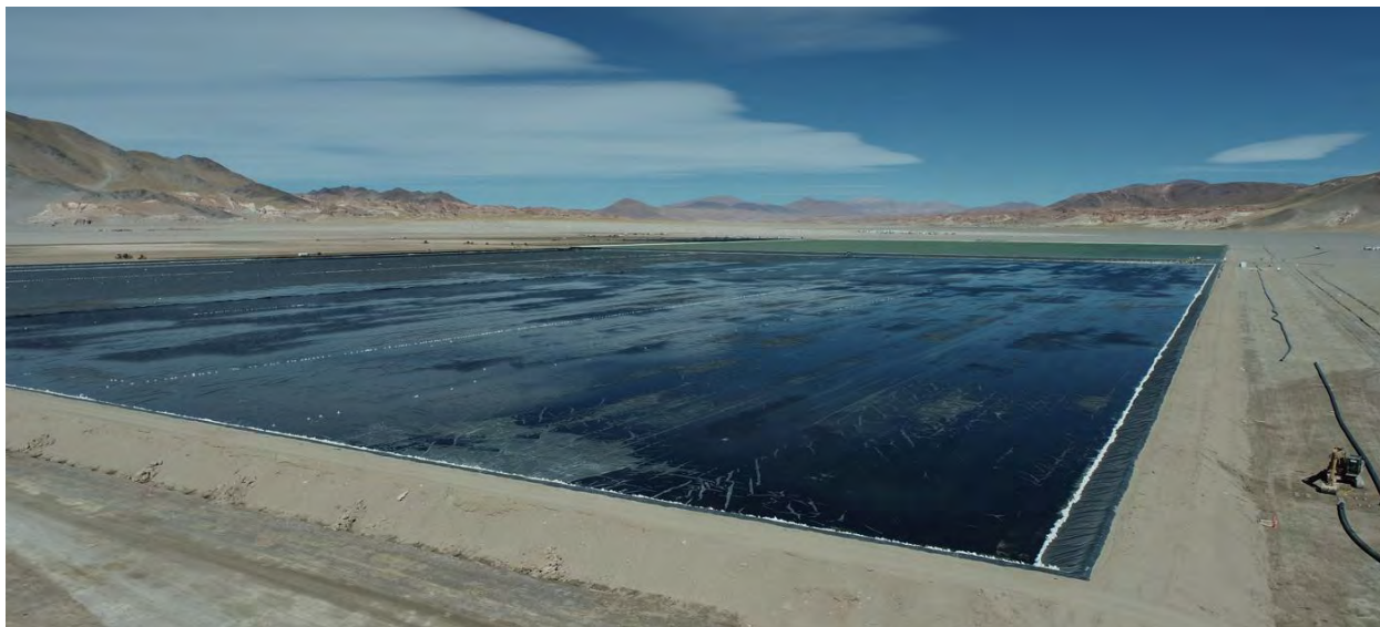
Foto III-1. Impermeabilización de piletas H11 y H12 (julio 2022).
