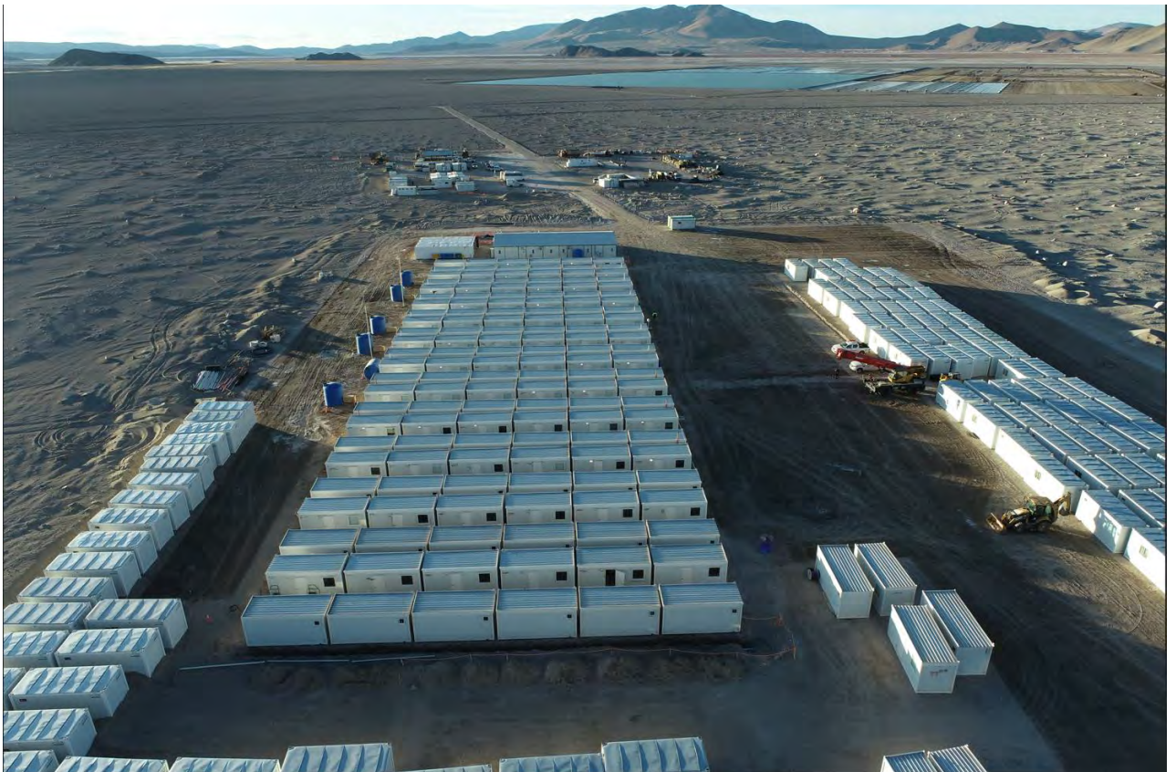
Foto III-3. Campamento de construcción (temporario).
