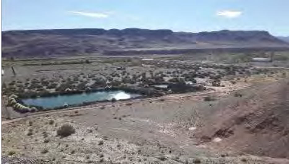
Foto II-77 Vista panorámica del depósito de efluentes cloacales en la Villa de Antofagasta de la Sierra
