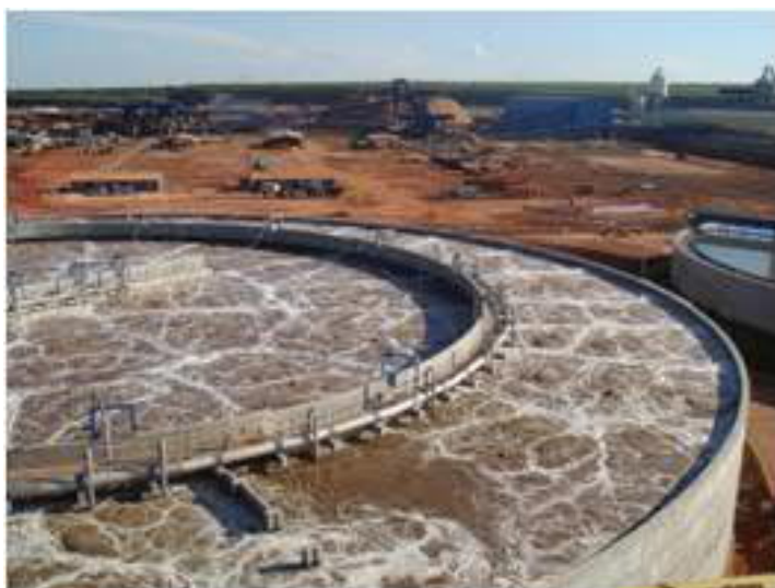
Figura 13 – Tanque de aeração. Fonte: Pöyry, 2018.
