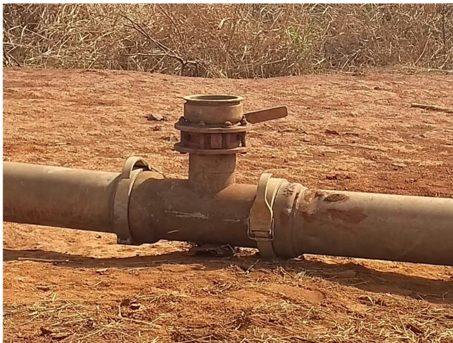
Figura 9 – Detalhe do hidrante usado para cada posição no sistema de fertirrigação autopropelido.
