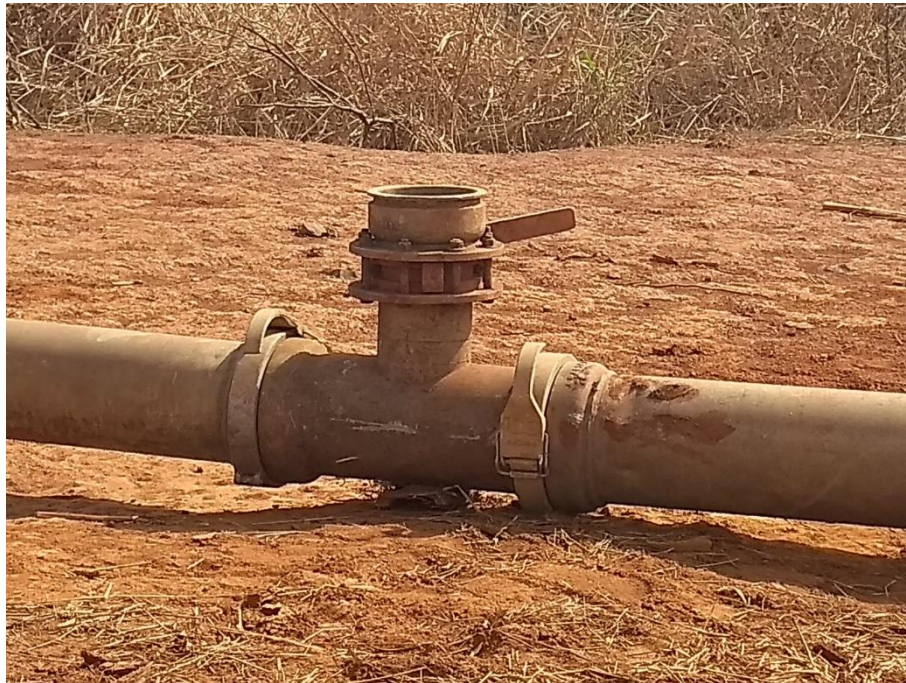
Figura 32. Detalhe do hidrante usado para cada posição no sistema de fertirrigação autopropelido.
