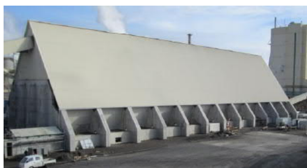
Figura 7 – Silo de cavacos. Fonte: Pöyry, 2018.
