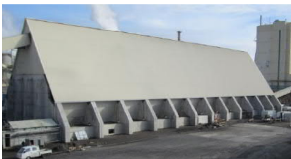
Figura 4 – Silo de cavacos. Fonte: Pöyry, 2018.
