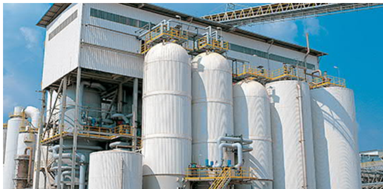
Figura 5 – Planta de cozimento dos cavacos de madeira. Fonte: Pöyry, 2018.
