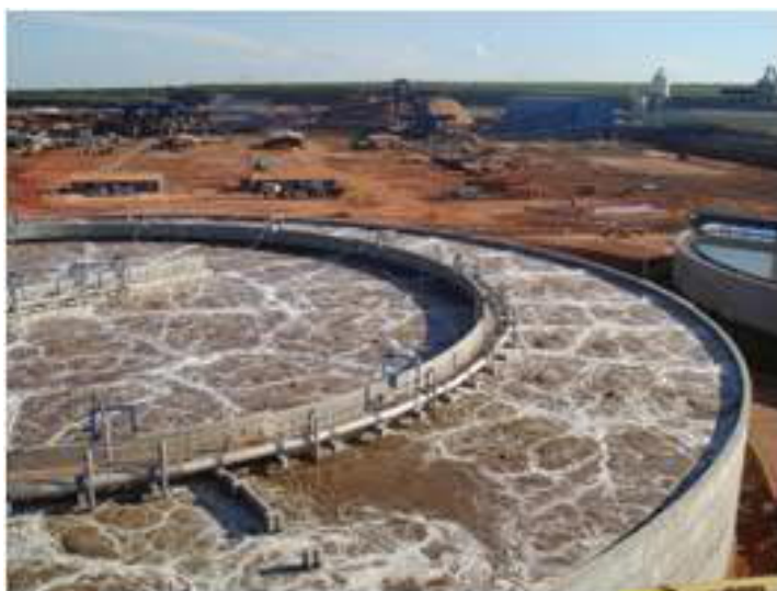
Figura 9 – Tanque de aeração. Fonte: Pöyry, 2018.
