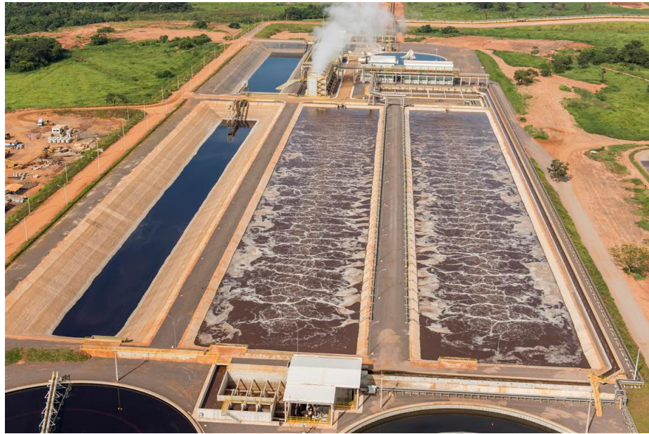
Figura 27 –Tanque de aireación
