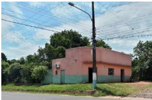
Figura 73 – Vivienda en esquina con fachada tipo tapa
