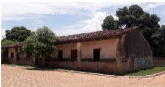
Figura 64 – Vivienda colonial con galería frontal. Av. Padre Sánchez e/Uruguay. Belén
