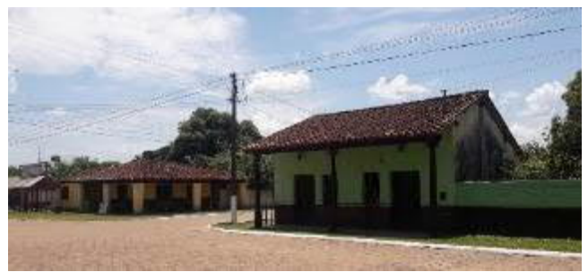
Figura 67 – Vivienda colonial con galería frontal con detalles de columnas al estilo jesuita (Lat. 23°28'9.72"S Long 57°15'47.76"O)
