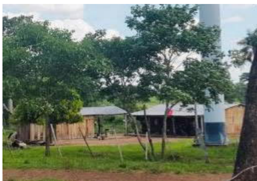
Vivienda de condiciones regulares
