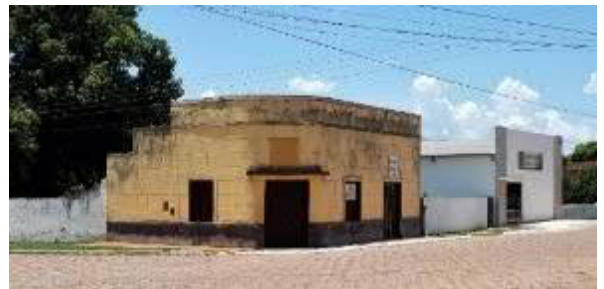
Figura 65 – Vivienda en esquina con fachada tipo tapa (Lat 23°28'12.57"S Long 57°15'45.89"O)
