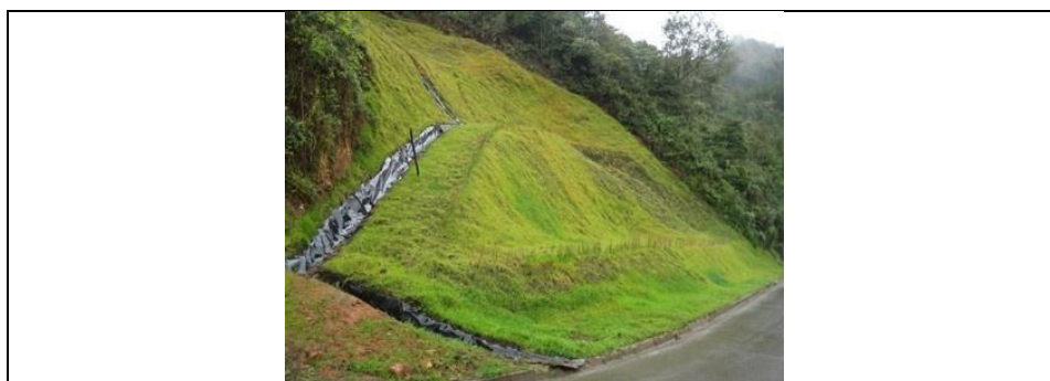
Figura 10-6 Talud con revegetalización a través de biomortero.
