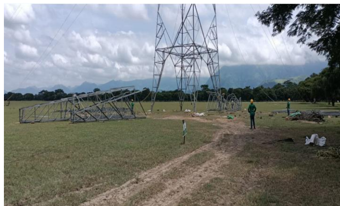
Fotografía 7-10 Pre-armado brazos de torre
