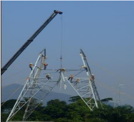
Fotografía 7-8 Montaje de torres con grúa
