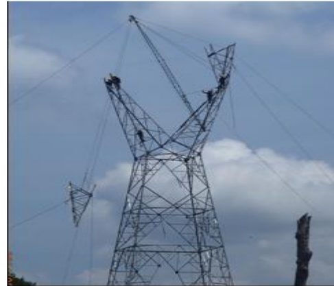
Fotografía 7-9 Montaje de torres con pluma
