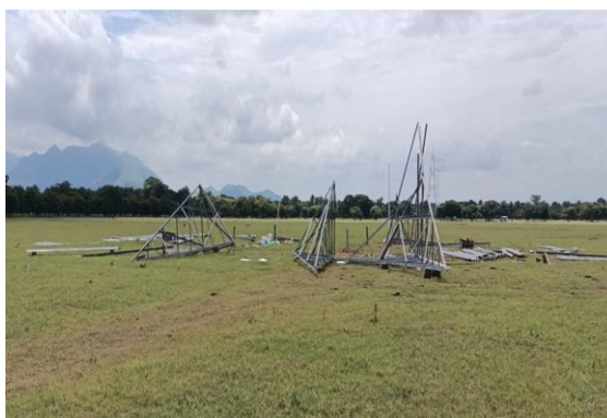
Fotografía 7-7 Pre-armado de piezas
