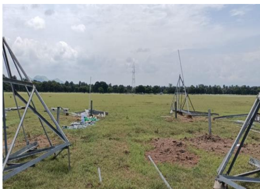
Fotografía 7-6 Centro de torre libre para pre-armado
