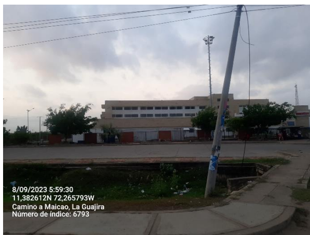
Fotografía 5-10 (UP204) Tejido urbano continuo en Cortes y llenos antrópicos (E: 5080072.356 -N: 2815932.831)
