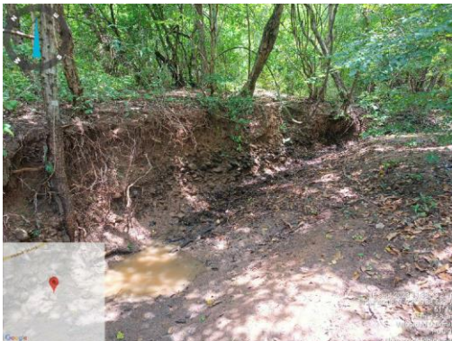
Fotografía 2-86 Registro fotográfico ocupación de cauce
