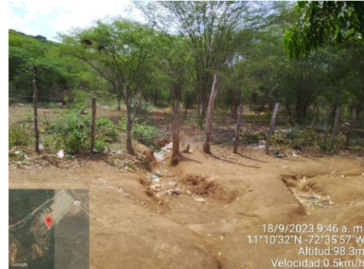
Fotografía 2-85 Registro fotográfico ocupación de cauce
