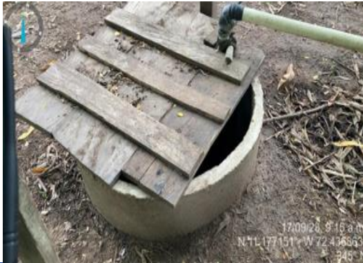
Fotografía 5-3 Aljibe con ID AL_023
