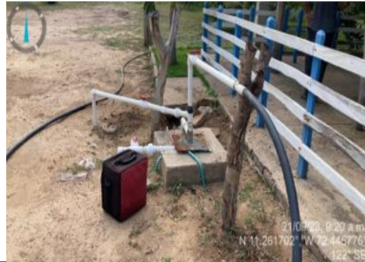
Fotografía 5-2 Pozo con ID PZ_070
