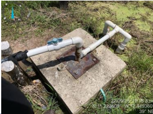
Fotografía 5-1 Pozo con ID PZ_086
