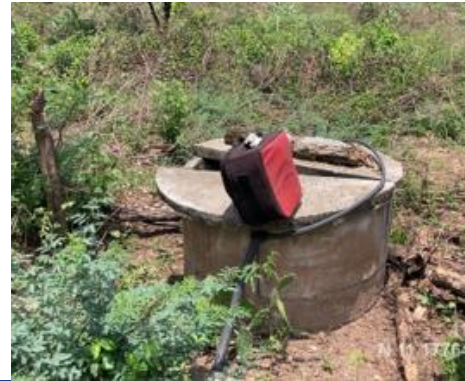
Fotografía 5-4 Aljibe con ID AL_013
