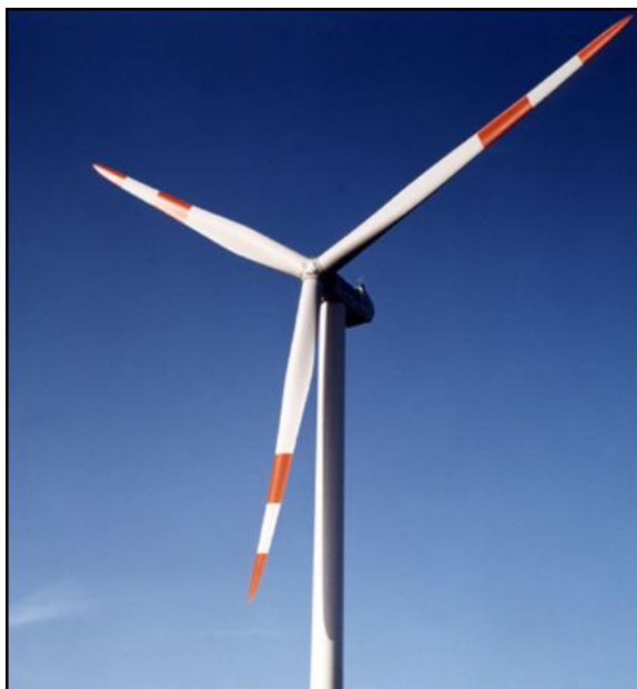
Figura PM-B3 2. Patrones de pintura en las aspas de los aerogeneradores
