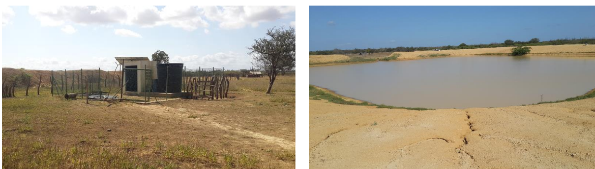
Imagen 5-2. Sistema de bombeo de agua para consumo humano por medio de paneles solares en la ranchería de Aipishimana
