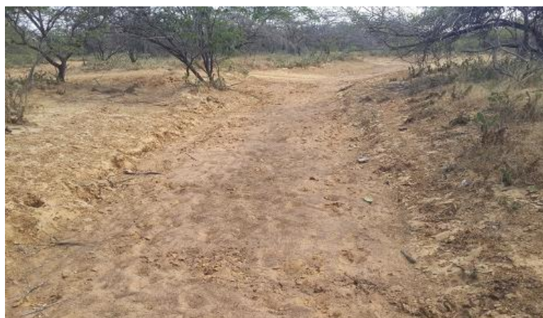
Imagen 2-5. Visitas de campo a los puntos de ocupación de cauce en la vía de acceso al parque eólico. Arroyo Santana, en la ranchería de Soshinchon enero de 2019
