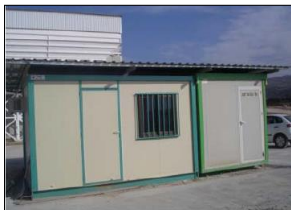
Figura 3-54. Caseta de control
