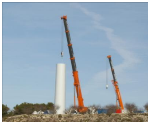
Figura 3-28. Grúa para izado de tramos de torre
