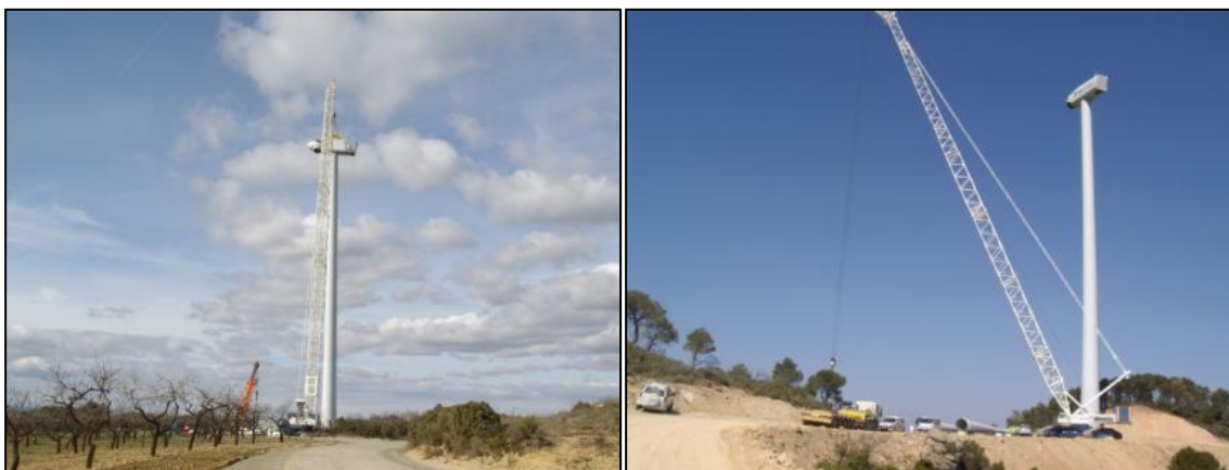
Figura 3-29. Grúa para izado de la góndola
