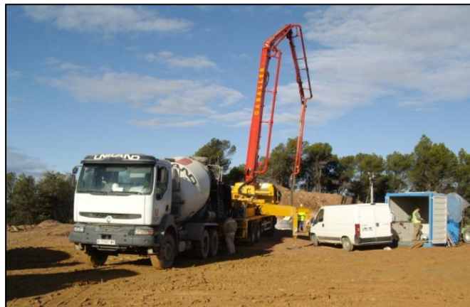
Figura 3-26. Camión mixer y bomba de concreto
