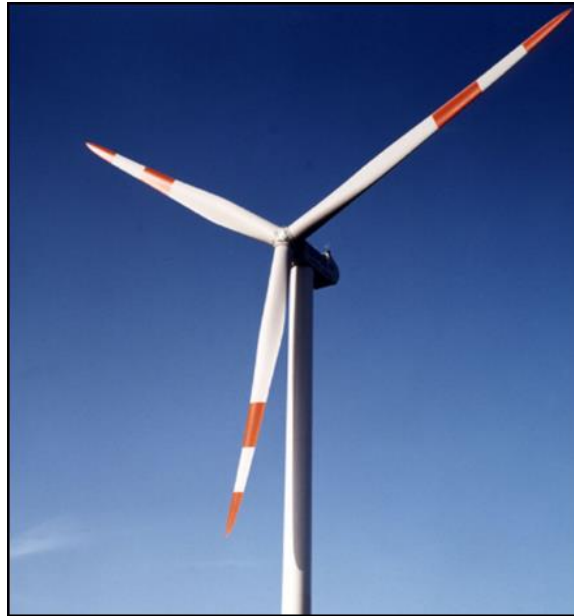
Figura PM-B3 2. Patrones de pintura en las aspas de los aerogeneradores
