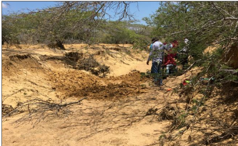
Imagen 2-11. Ejecución de la calicata Número 8
