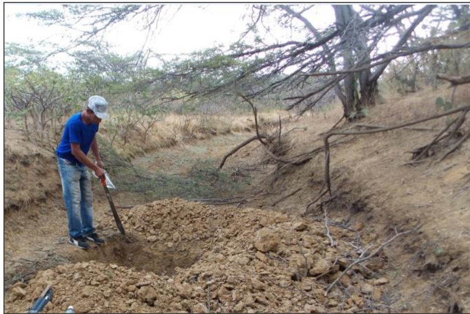
Imagen 2-12. Ejecución de la calicata Número 9
