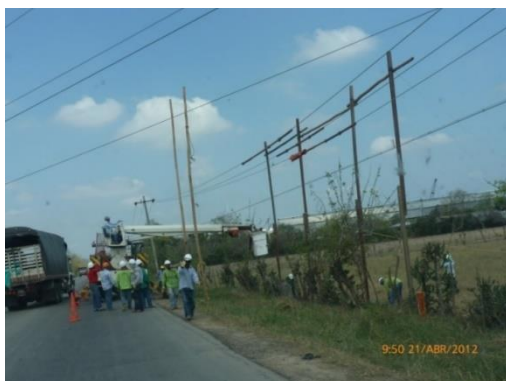
Figura 3-61 Sistema de protección en vías Nacionales
