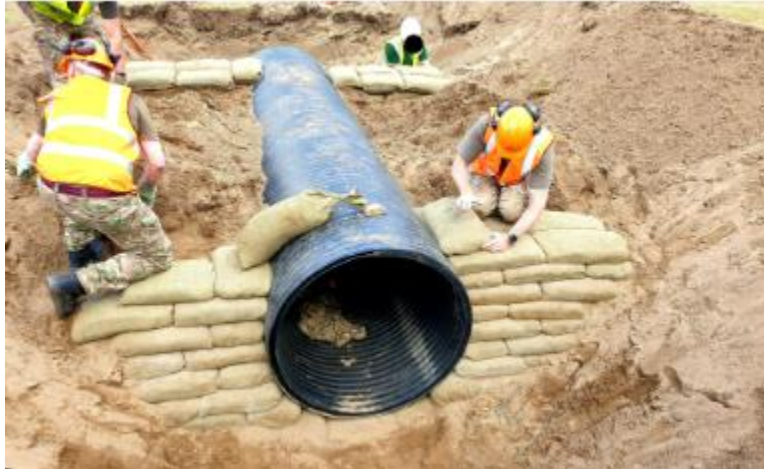
Fotografía 3-20 Alcantarilla en tubería polietileno y saco suelo-cemento
