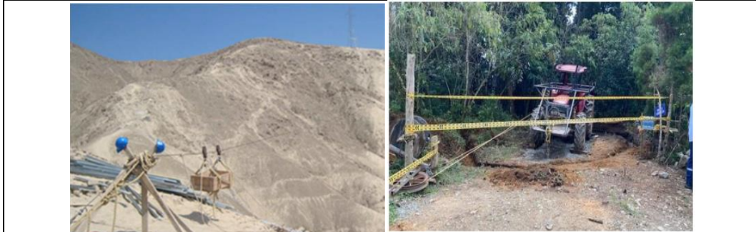
Fotografía 3-15 Ejemplo de instalación de Teleférico
