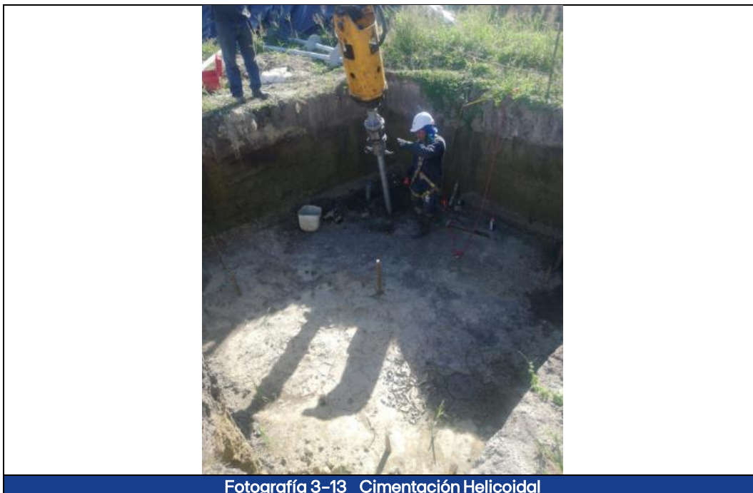
Fotografía 3-13 Cimentación Helicoidal
