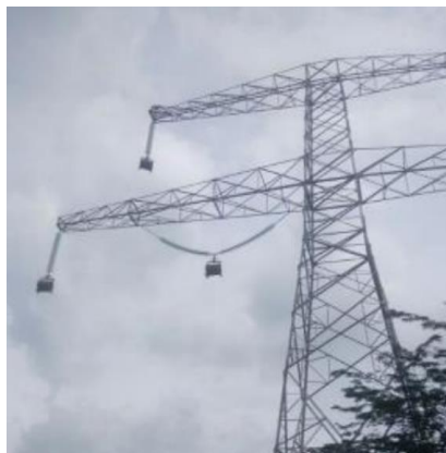
Fotografía 3-19 Pre- armado brazos de torre
