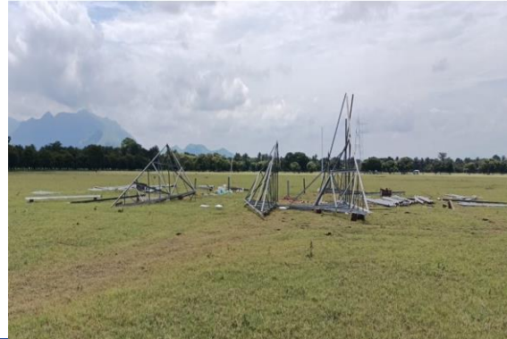
Figura 3-53 Pre-armado de piezas
