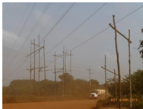
Figura 3-62 Sistema de protección en vías Secundarias
