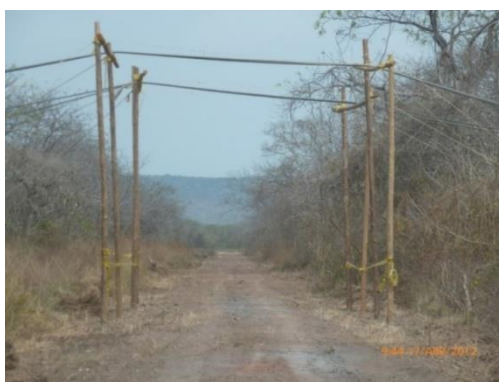
Figura 3-63 Sistema de protección en vías Tipo 4s
