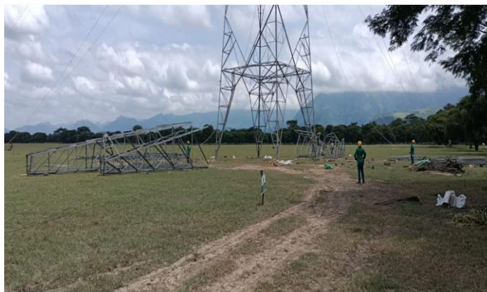
Fotografía 3-18 Pre- armado brazos de torre
