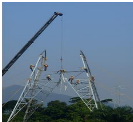
Fotografía 3-16 Montaje de torres con grúa
