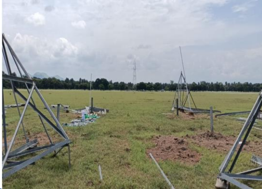
Figura 3-52 Centro de torre libre para pre-armado
