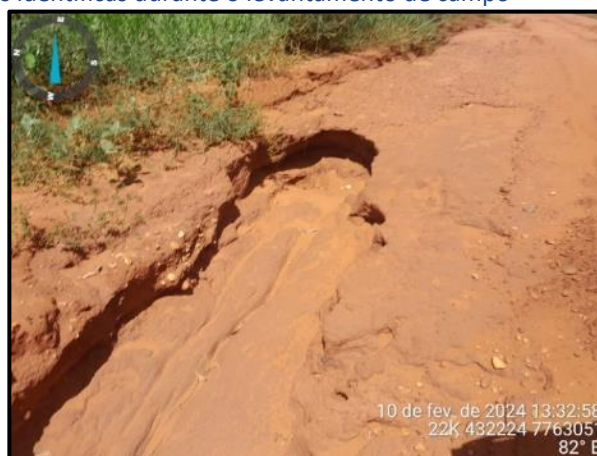
B) Canal de drenagem na lateral do acesso (P107)
