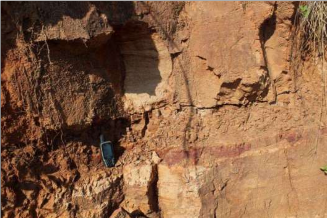
Figura 41 - Detalhe do afloramento 01 indicando arenito com camada argilosa
